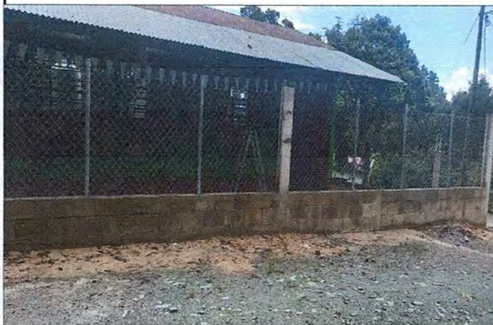
Foto 3: Mejoramiento de cerco de malla en el área Perimetral.
