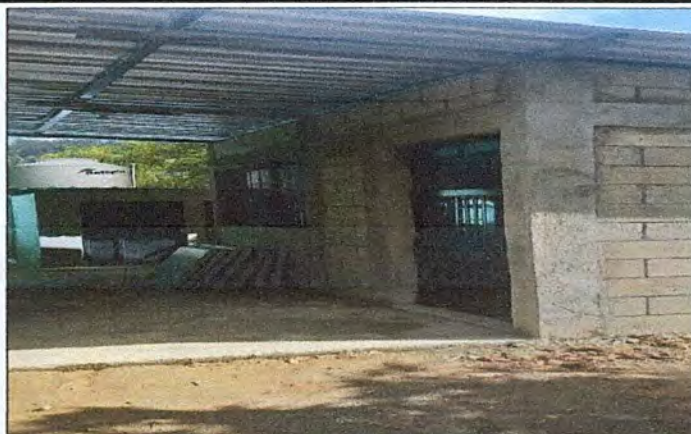
Foto 2: Mejoramiento de Instalaciones de cocina de block
