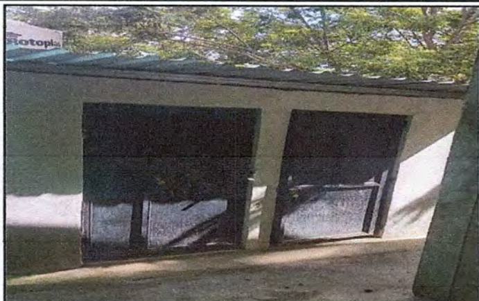
Foto 1: Mejoramiento e instalación de techo de baños, instalación de tinaco.
