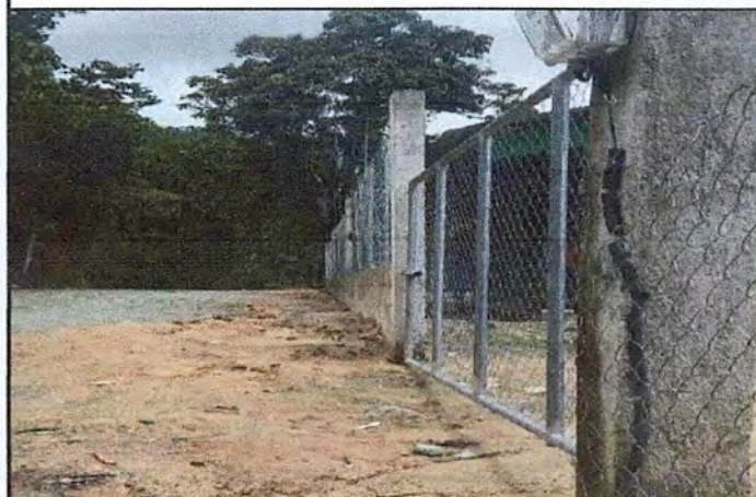
Foto 4: Mejoramiento de cerco de malla en el área Perimetral.
